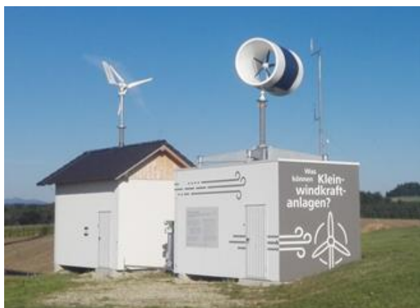
Abbildung 11: Messaufbau Projekt SmallWindPower@Home
